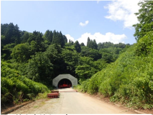
竹之高地トンネル 団子山方面より
