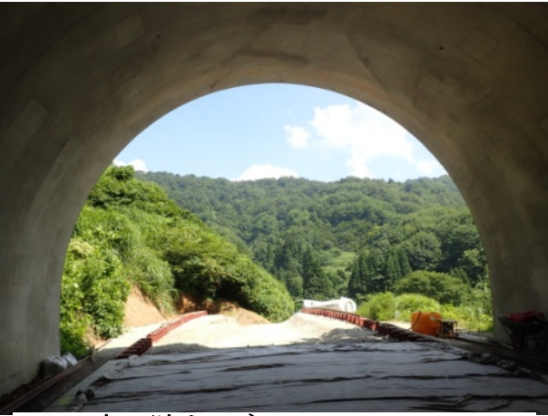
奥の院トンネル 猿倉を望む
